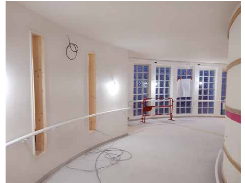
Les travaux ont permis de moderniser la rotonde qui accueille le Guichet unique
